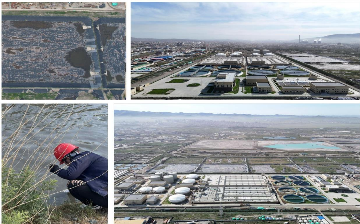
Abbildung 30. Schlammtrocknungsbecken der neuen und alten zentralen Abwasserreinigungsanlage
