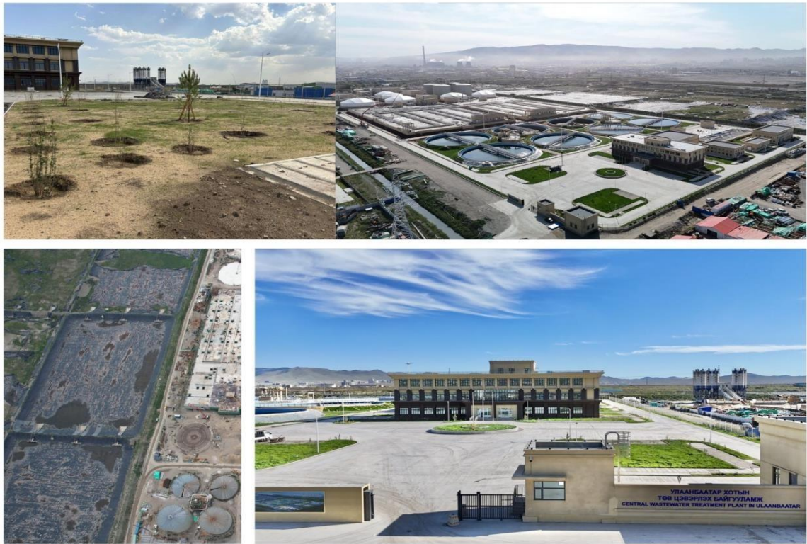
Abbildung 29. Neue Zentrale Abwasserreinigungsanlage (ABWASSERBEHANDLUNGSANLAGE)
