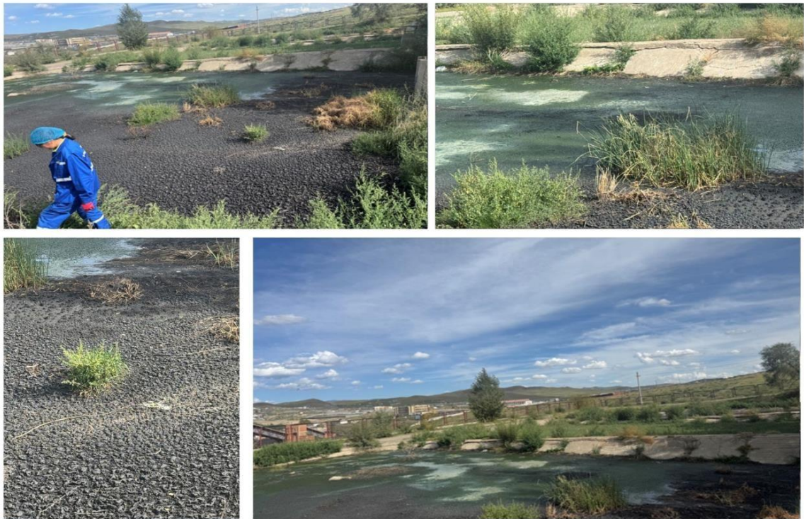
Abbildung 31. Schlamm-trocknungsbereich der Abwasserreinigungsanlage Biokombinat
