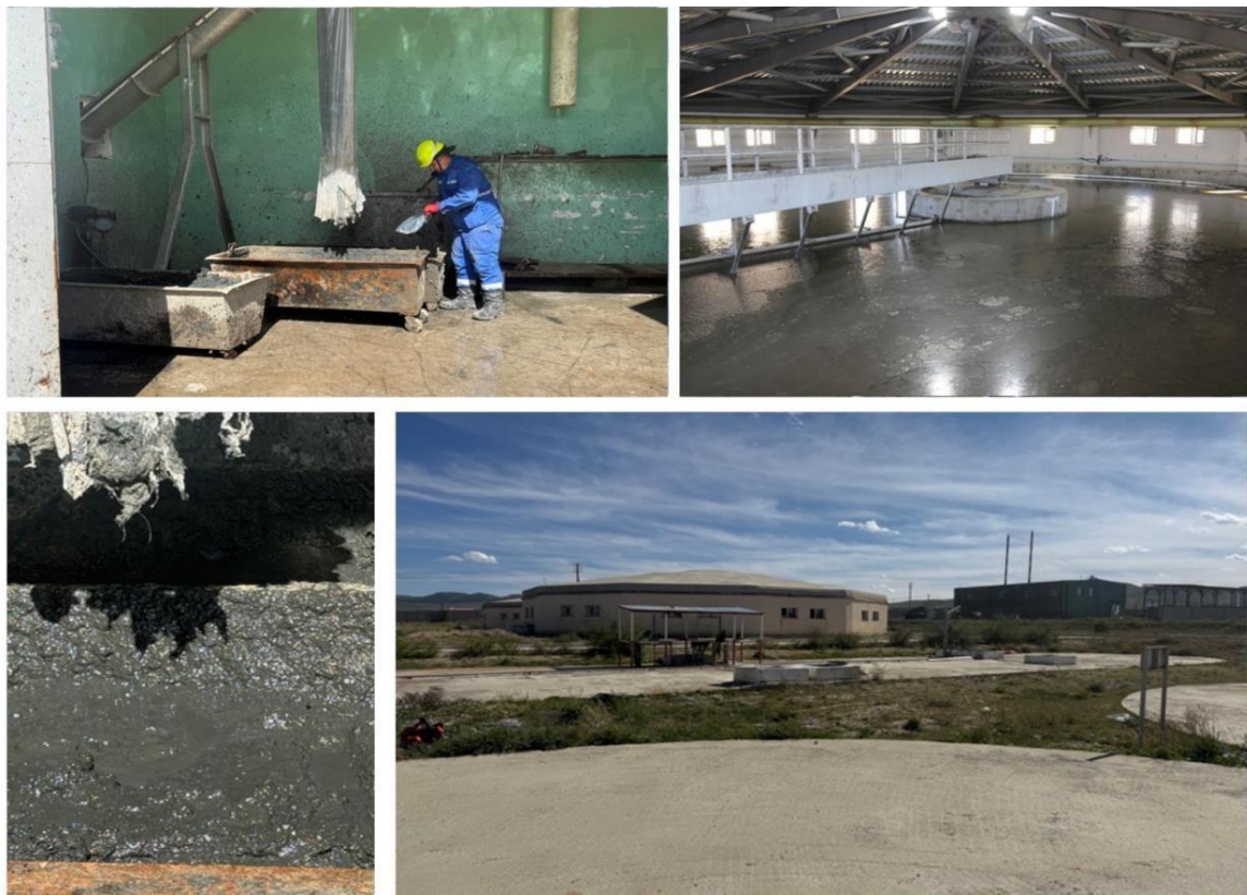
Abbildung 32. Schlamm-trocknungsbereich der Abwasserreinigungsanlage Moringiin Davaa
