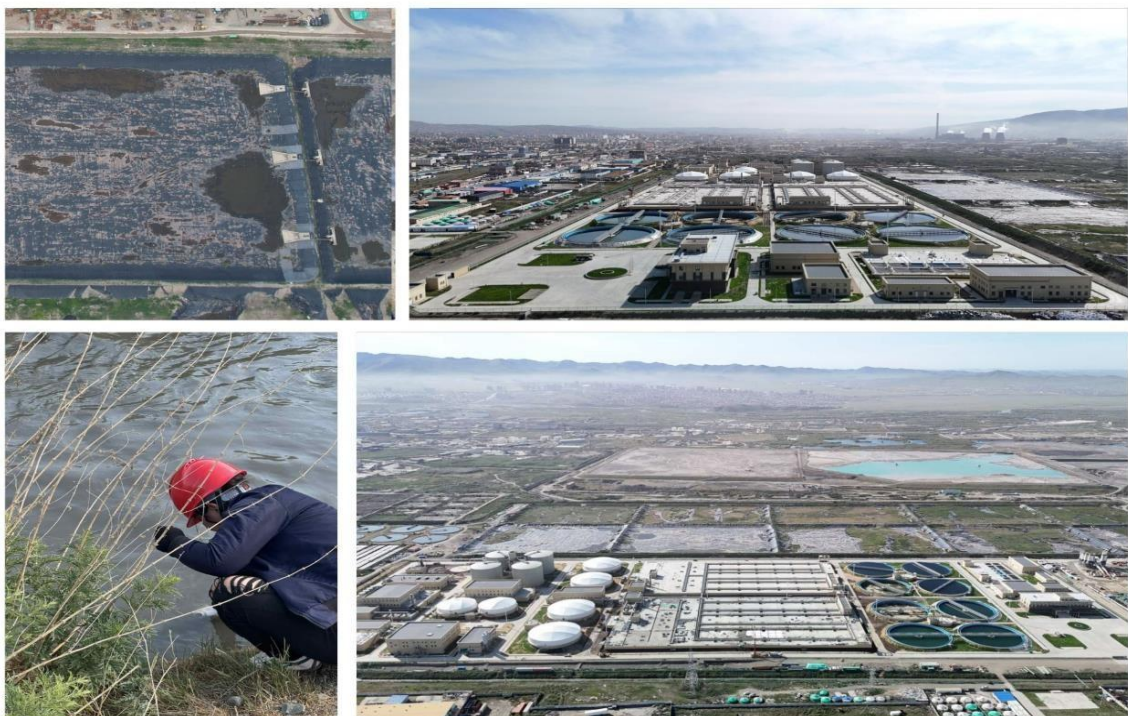
Abbildung 30. Schlamm-trocknungsbecken der neuen und alten zentralen Abwasserreinigungsanlage
